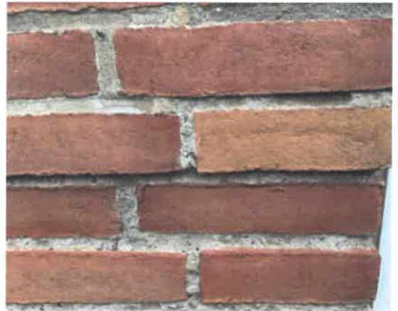
Forvitrede fuger
